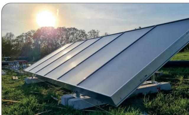
Kollektorfeld FA DUO ST mit Betonfundament
